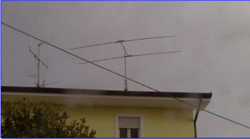
Μονοbander MOXON σε νεροσωλήνα! Με rotor-a περιστροφής.
