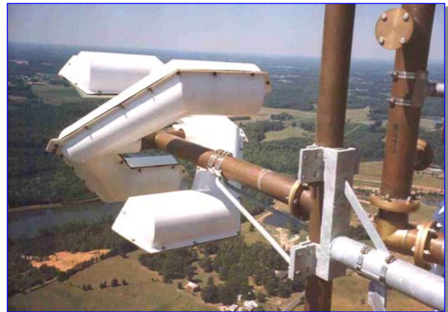
Κεραία κυκλικής πολώσεως TV και κεραία TV με ειδικό προστατευτικό θερμαινόμενο κάλυμμα Radome κυκλικής πολώσεως για προστασία από τον πάγο.
