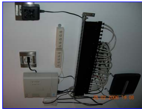
ΜΕΤΑ ΚΑΘΕ ΚΑΛΩΔΙΟ ΣΤΟ PATCH PANEL
